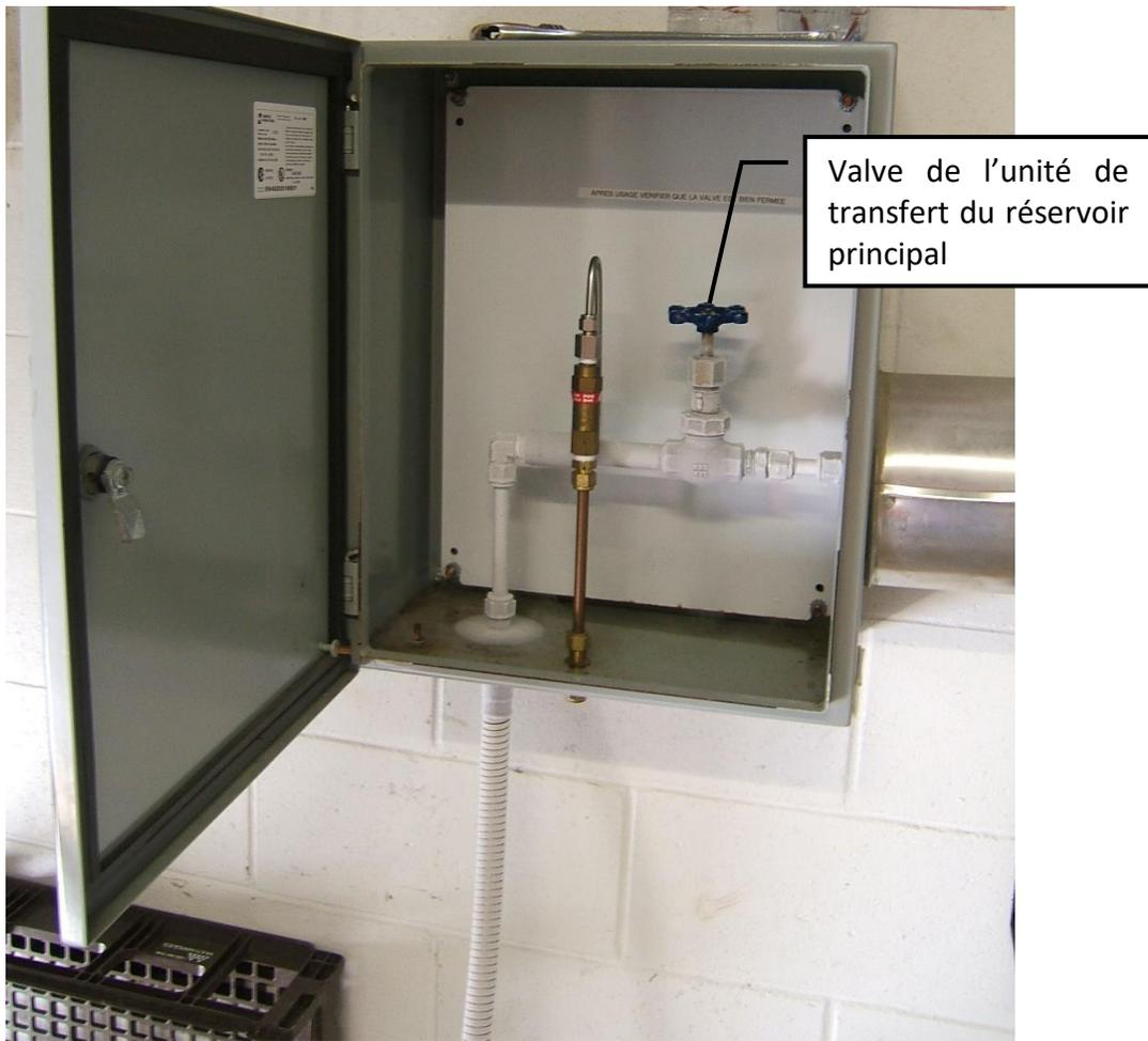
**Photo 2 :** Unité de transfert de l'azote liquide
