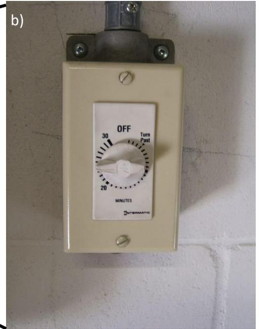
**Photo 3 :** a) Système d'évacuation b) Minuterie de 30 minutes
