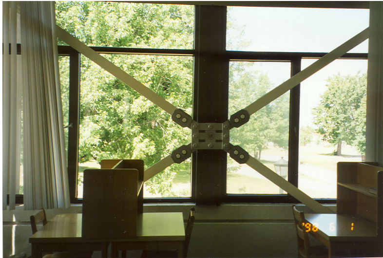
Dispositif à friction Pall
